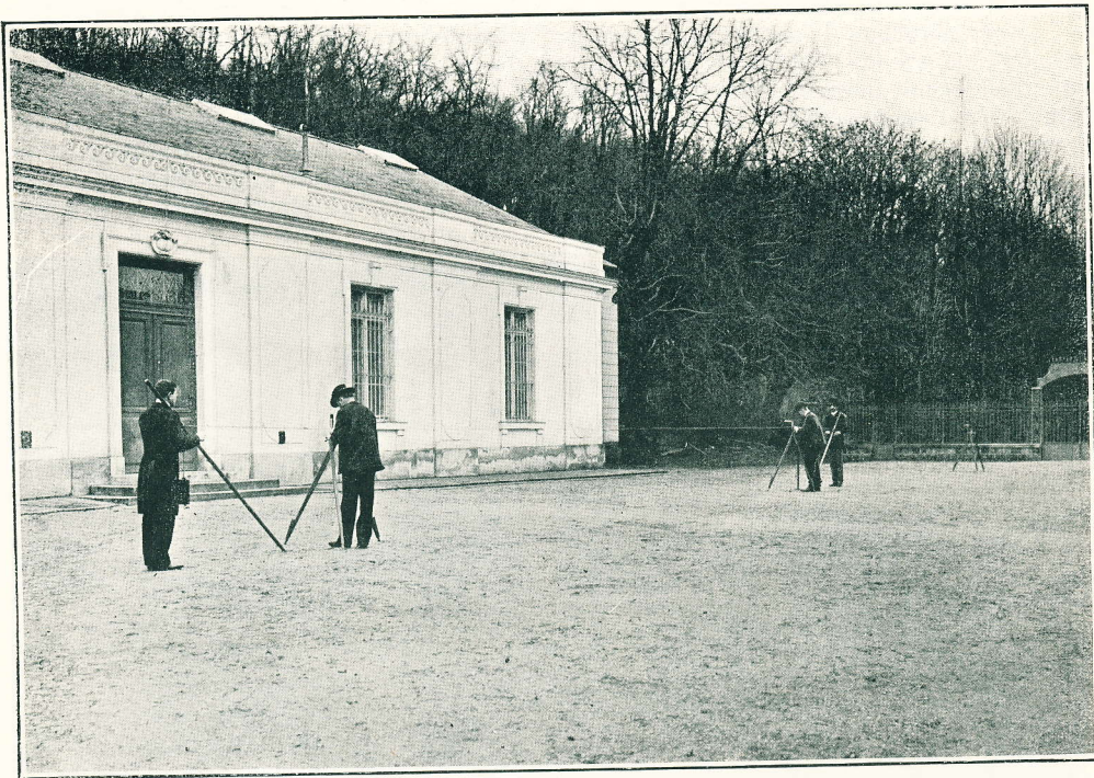
AU PAVILLON DU PARC DE SAINT-CLOUD. — LA MESURE D'UNE BASE SUR LE TERRAIN, À L'AIDE D'UN FIL TENDU. Moins variables encore sous l'action de la température que les mètres les mieux vérifiés, les fils d'acier au nickel, dont l'inventeur est M. Guillaume, l'un des savants du Bureau international, permettent de déterminer les distances avec la plus rigoureuse exactitude. Une mission russe en a fait récemment usage au Spitzberg.
